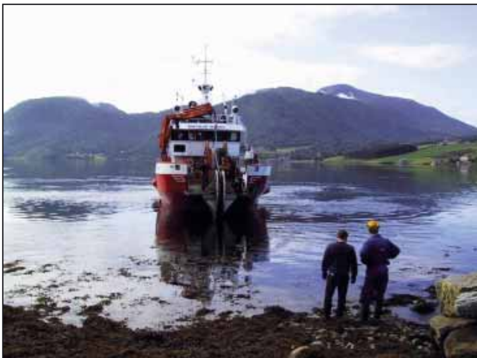
Legging av sjøkabel over Rødvenfjorden
